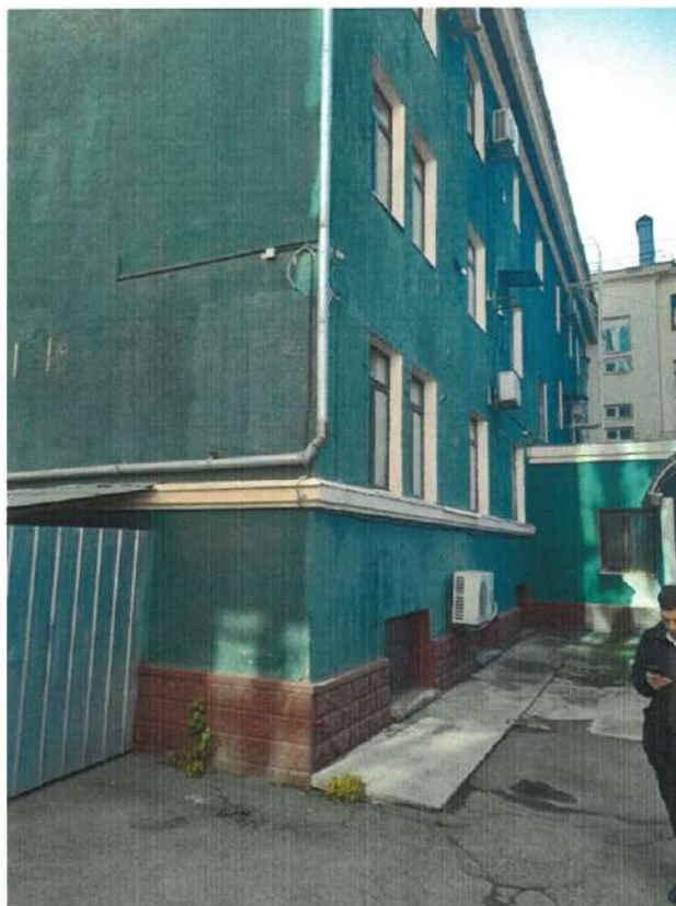
Фото 7. Здание со стороны дворового фасада и одноэтажная пристройка в осях 4-5
