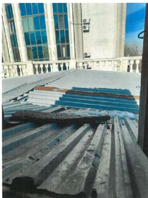
Фото 8. Кровельное покрытие из листов профилированного настила на здании по ул.Кунаева,181
