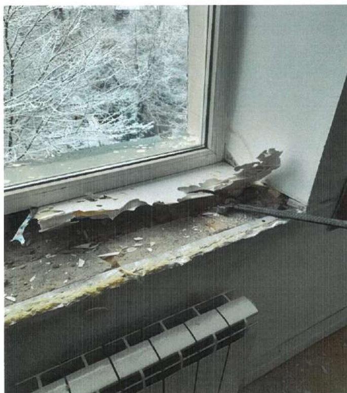
Фото 6. Кирпичная кладка подоконника на мансардном этаже выбирается руками
