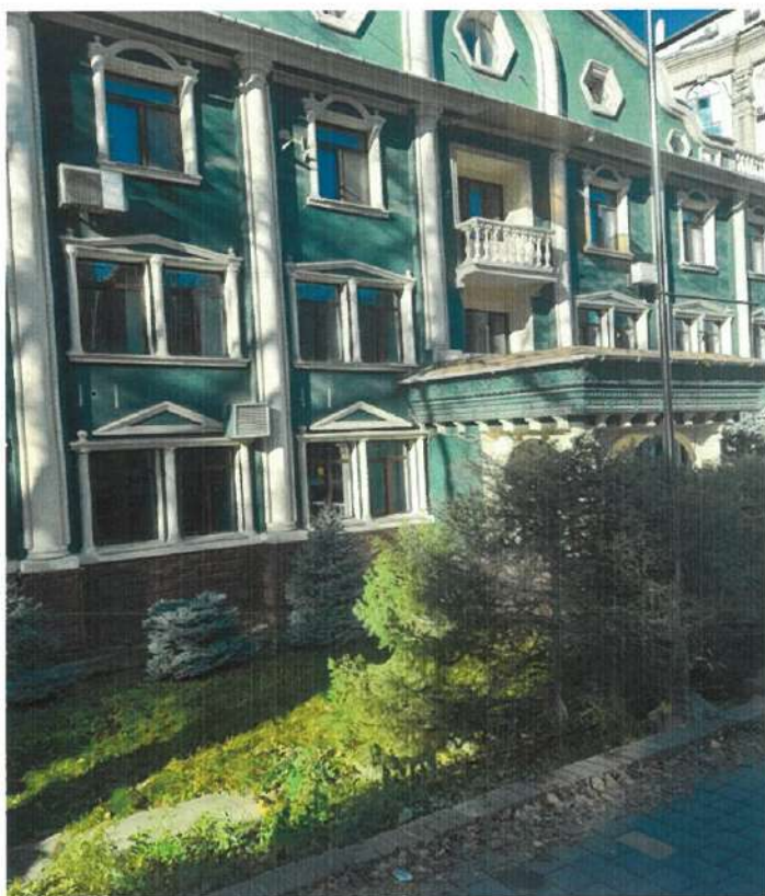
Фото 1. Здание по ул. Кунаева, 181 со стороны главного фасада
