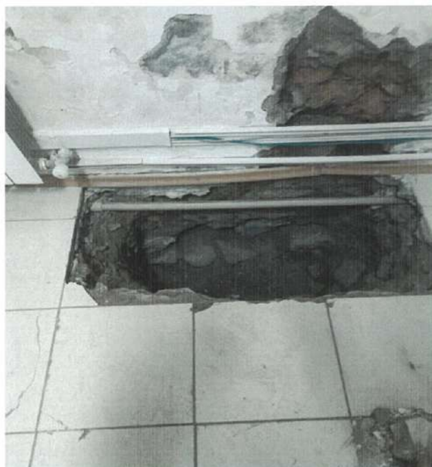
Фото 3. Ленточный фундамент из бутобетона с заполнителем из рваного камня
